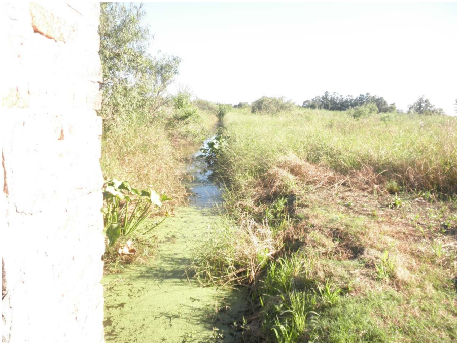
Imagen que muestra el canal informal utilizado para recibir por el proceso de bombeo los excedentes de los piletones producto de los desbordes y reconducidos hacia el Río Negro.
