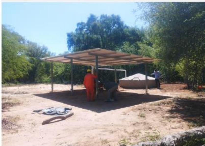
Foto 1 y 2: Cisternas para recolección de agua de lluvia
