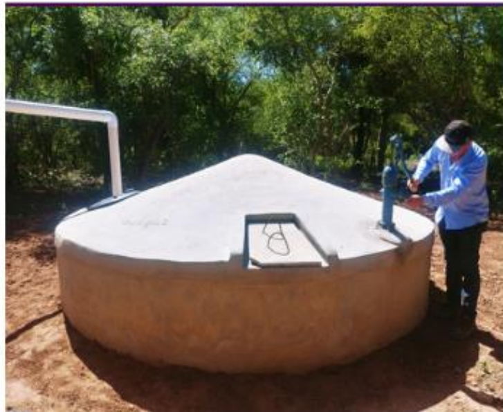
Foto 1 y 2: Cisternas para recolección de agua de lluvia
